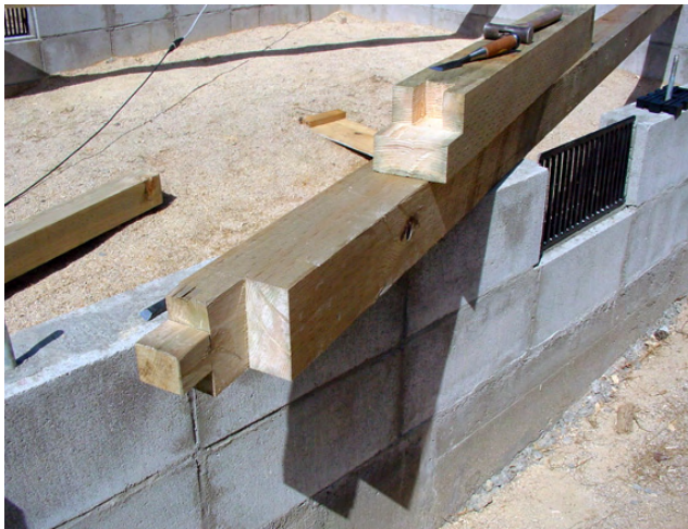
数少ない大工仕事。土台は防腐処理済み
