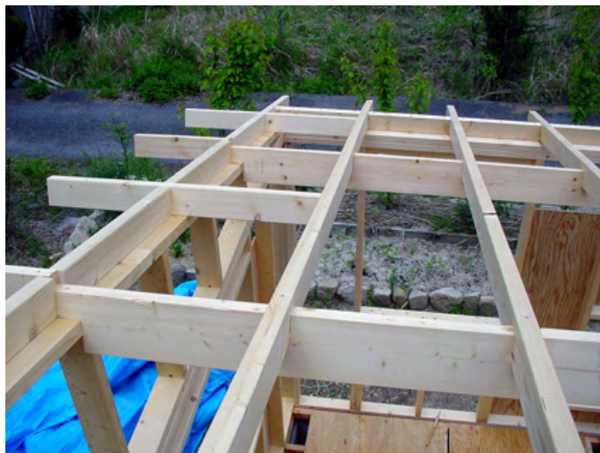
屋根の構成、梁の端部は下側を削り、上に材を追加している
