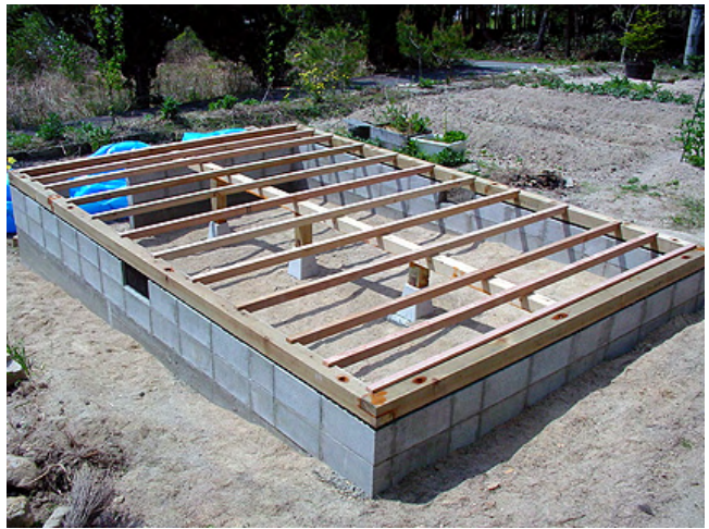
土台の完成、黄色い塗装は防蟻剤
