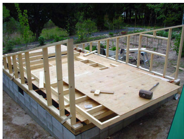
小屋の部分を仮置きして出来上がりを確かめてみる
