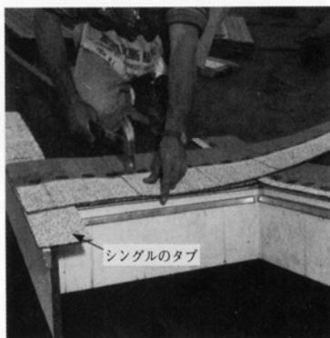
4-11図 シングルのタブを切って、けらば側のトリムの出っ張っている部分にかぶせる。
