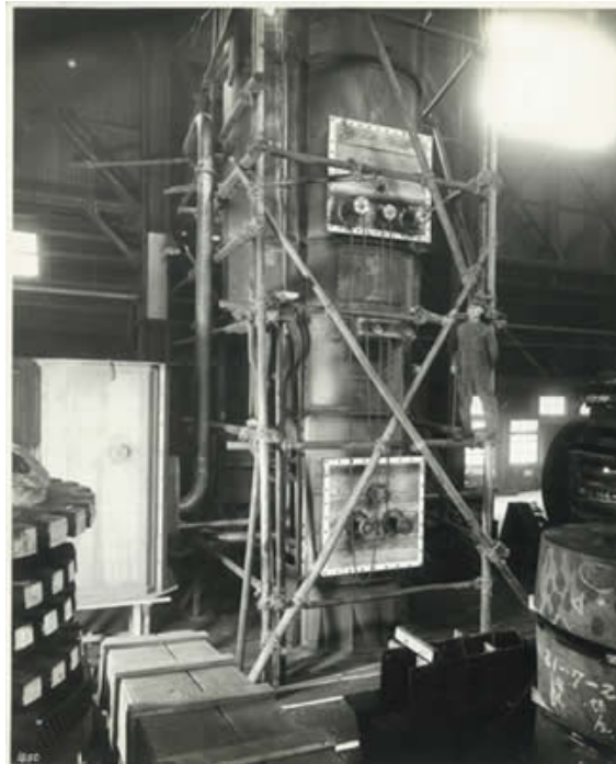
南満州鉄道（撫順石炭液化）3500m 3 /h 水素ガス分離装置
