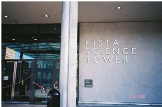
建設中のシスタ・サイエンス・タワー
