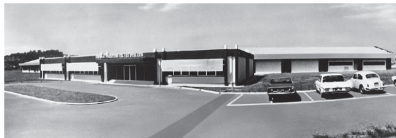
完成したシンガポール工場
